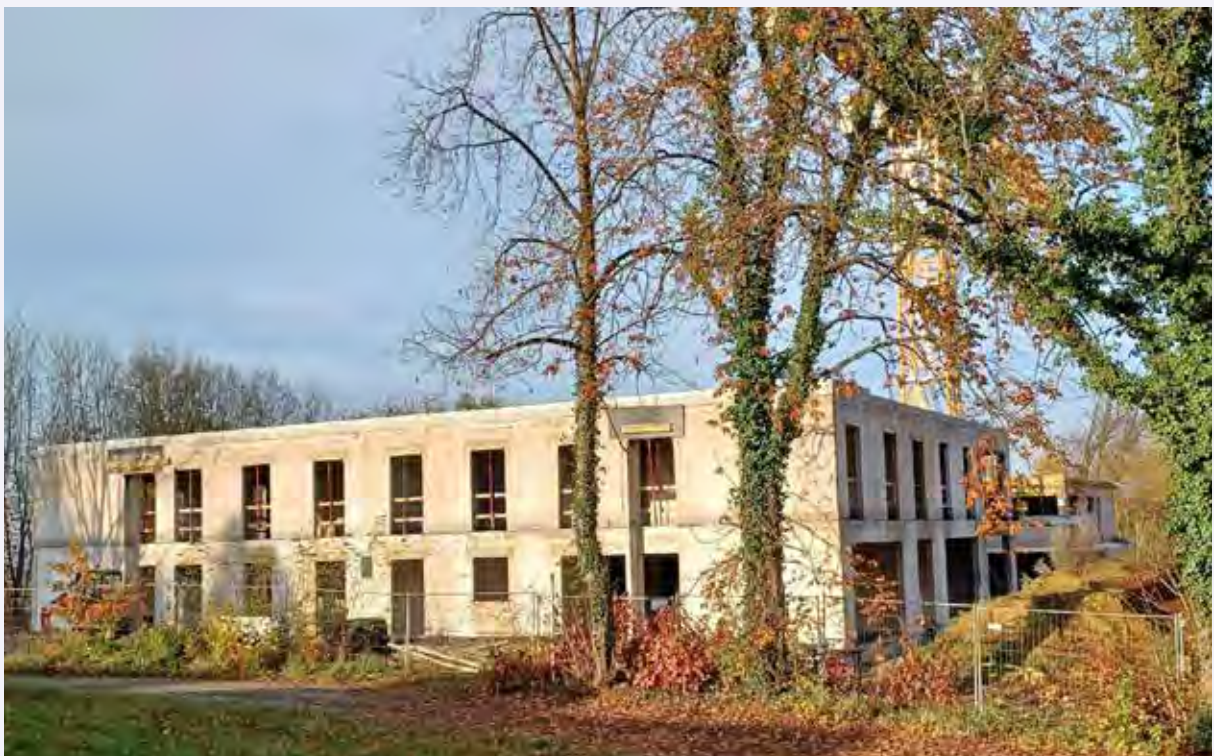
Einde van de ruwbouw in december 2023 © Ir. Architecte Jean-Michel Leriche
